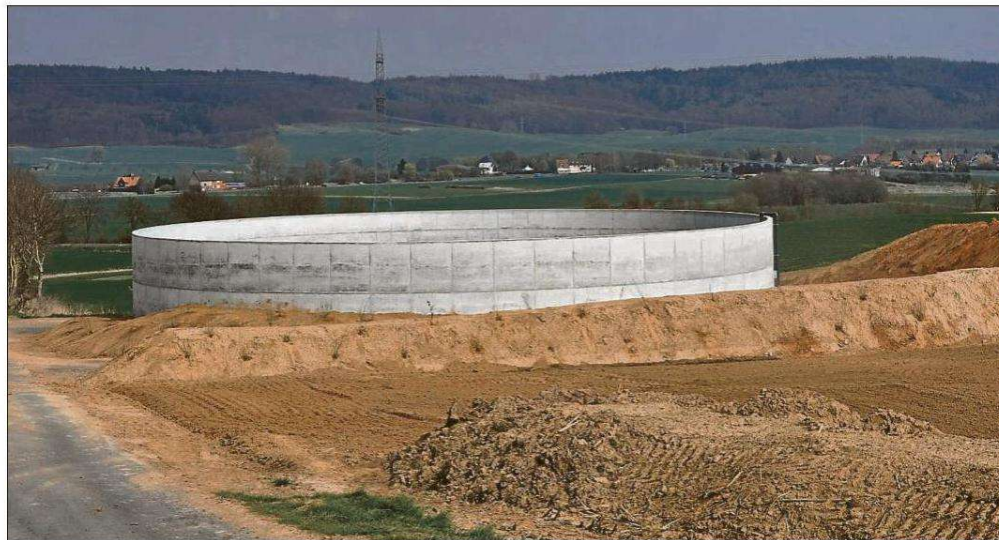
Ein Güllebehälter ist bereits in Betrieb, ein Stall ist noch geplant in der Waldecker Gemarkung (im Hintergrund Netze).
